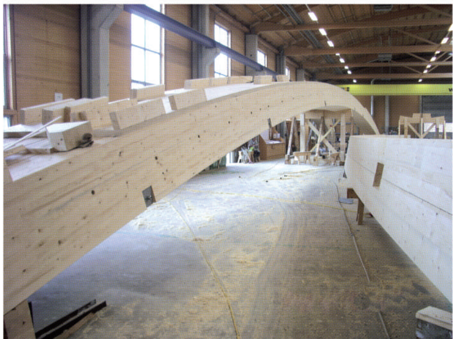
Bild 3 Bogen-Paar-Hälfte bei der weitgehenden Vorfertigung
