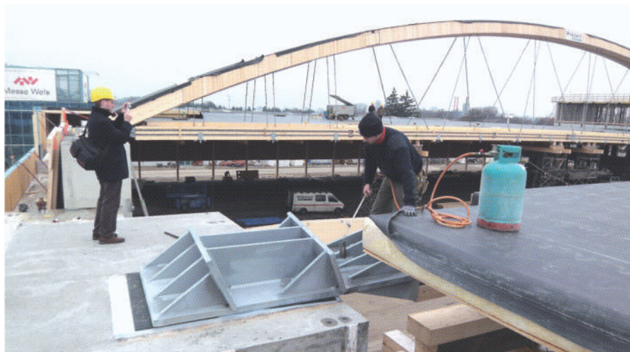
Bild 7 Das Kämpfer-Widerläge ist bereits an die Stahlzugbänder angeschlossen und wartet auf den Bogen.
