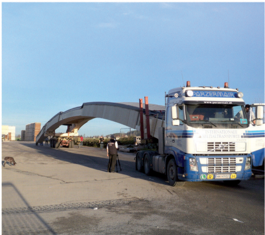
Bild 4 Transport XXL, auf den letzten Metern vorm Ziel musste zwecks „Durchkommens“ eine Stahlkonstruktion demontiert und später wieder aufgebaut werden. Technisch (Schutz der Bauteile) und wirtschaftlich hat sich der Sondertransport allemal gelohnt.
