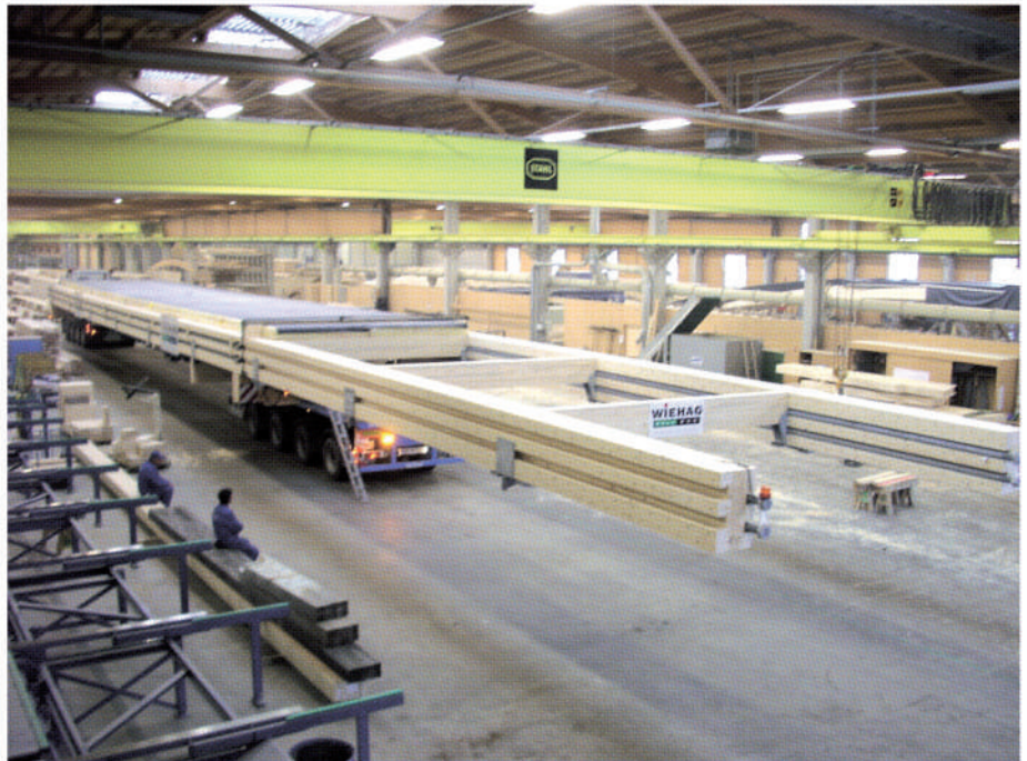
Bild 5 Auch die Flachdachflächen zwischen den Bogen-Paaren wurden weitgehend im Werk fertig gestellt.
