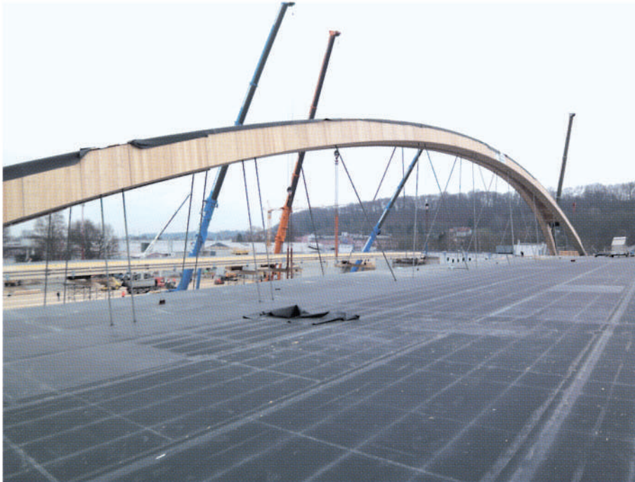
Bild 1 Das Flachdach der neuen Messehalle in Wels (A) mit 90 m Stützweite bei 30 m Einflussbreite und 1,55 kN/m 2 Schneelast hängt an drei Bogen-Paaren, natürlich aus BS-Holz.
