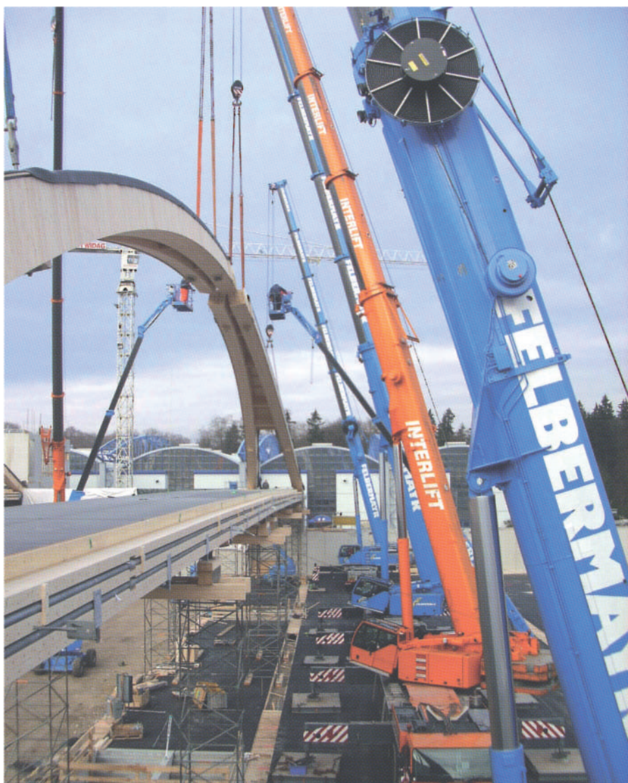
Bild 8 Zusammenfahren der Bögen, deutlich erkennbar der reine Hirnholz-Kontaktstoß als Scheitelgelenk, das einfachste Gelenk, das es gibt. 2 x 16 in Hirnholz eingefräste Appeldübel übertragen die Querkraftdifferenzen.
